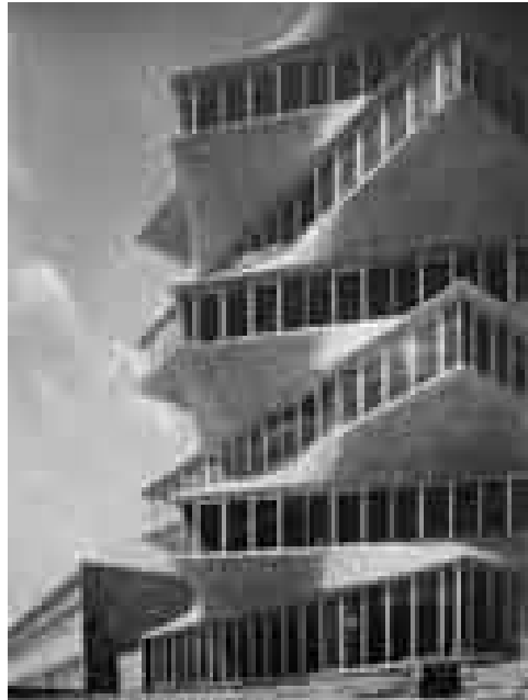
Figura 19: Laboratorios Jorba, Madrid, arquitecto Miguel Fisac, estado original.
