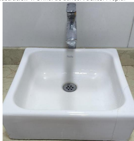
Ilustración 5: Grifos de agua. Fuente: Propia.
